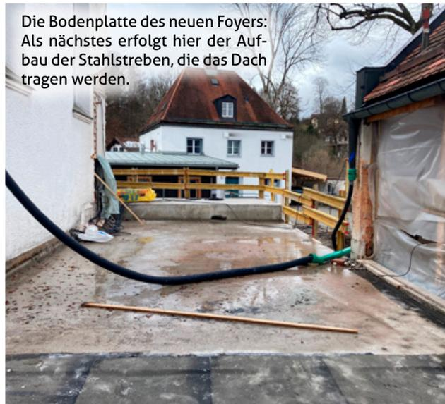
Die Bodenplatte des neuen Foyers: Als nächstes erfolgt hier der Aufbau der Stahlstreben, die das Dach tragen werden.
