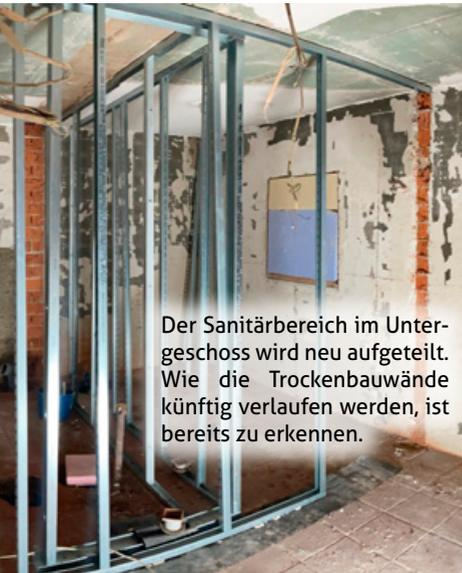
Der Sanitärbereich im Untergeschoss wird neu aufgeteilt. Wie die Trockenbauwände künftig verlaufen werden, ist bereits zu erkennen.
